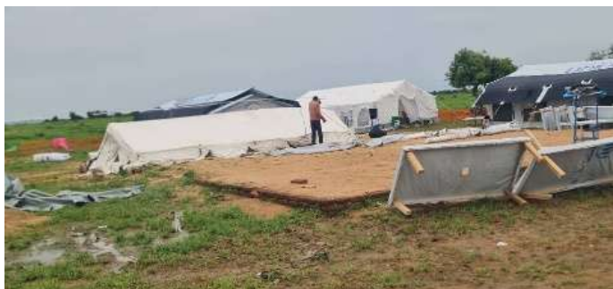
Image 3 : Destruction de l'UTC de Dougui suite au vent ,11 Août 2025
